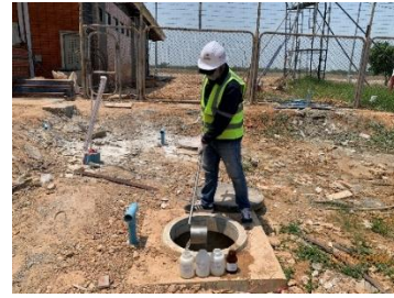
บ่อบำบัดน้ำก่อนเข้าสู่ระบบบำบัดน้ำเสียของอาคารที่พักผู้โดยสาร
