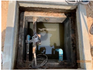
บ่อบำบัดน้ำหลังผ่านระบบบำบัดน้ำเสียของอาคารที่พักผู้โดยสาร
