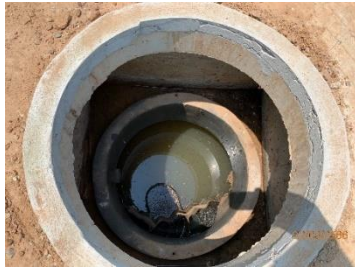
บ่อบำบัดน้ำก่อนเข้าสู่ระบบบำบัดน้ำเสียของอาคารที่พักผู้โดยสาร
