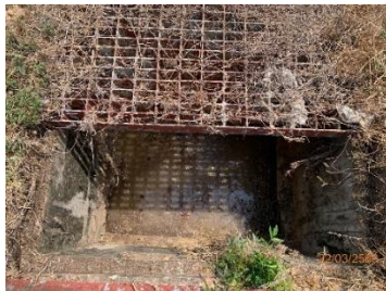
บ่อบำบัดน้ำหลังผ่านระบบบำบัดน้ำเสียของอาคารที่พักผู้โดยสาร
